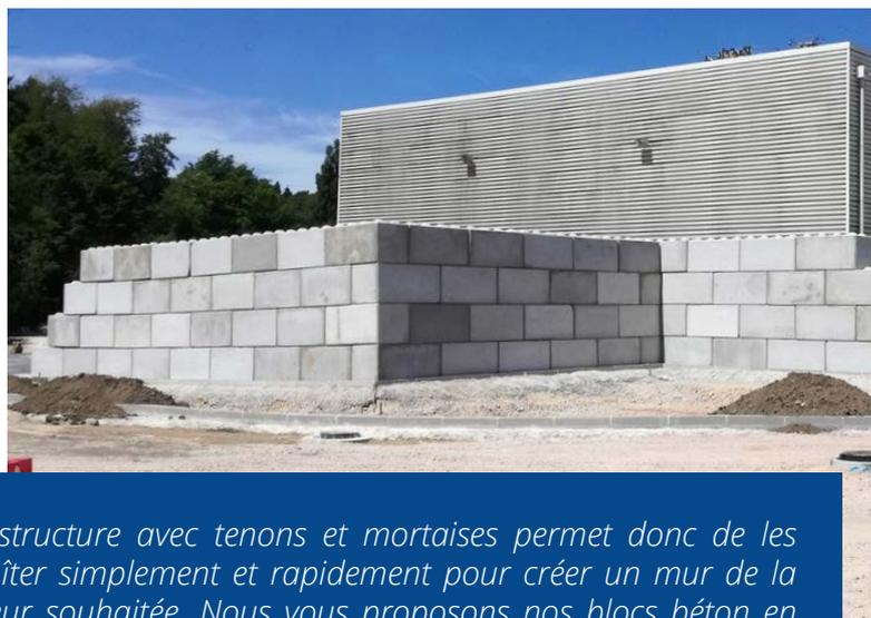
*Leur structure avec tenons et mortaises permet donc de les emboîter simplement et rapidement pour créer un mur de la hauteur souhaitée. Nous vous proposons nos blocs béton en deux dimensions standard (60 ou 80 cm) avec une longueur qui peut varier selon vos besoins. Vous obtiendrez ainsi un mur stable, modulable, démontable et durable.*
